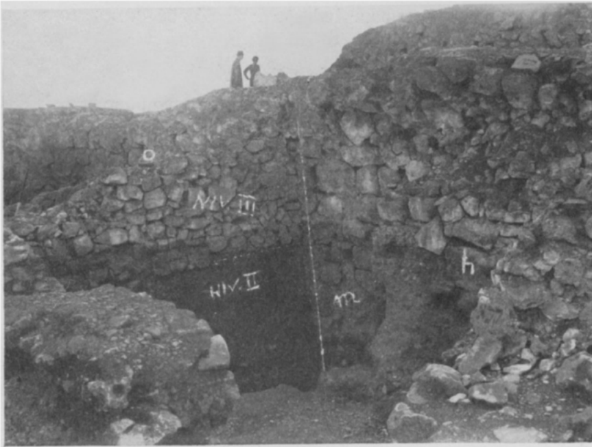
FIG. 4. — Citadelle, mur Nord du sanctuaire et parement (h).
