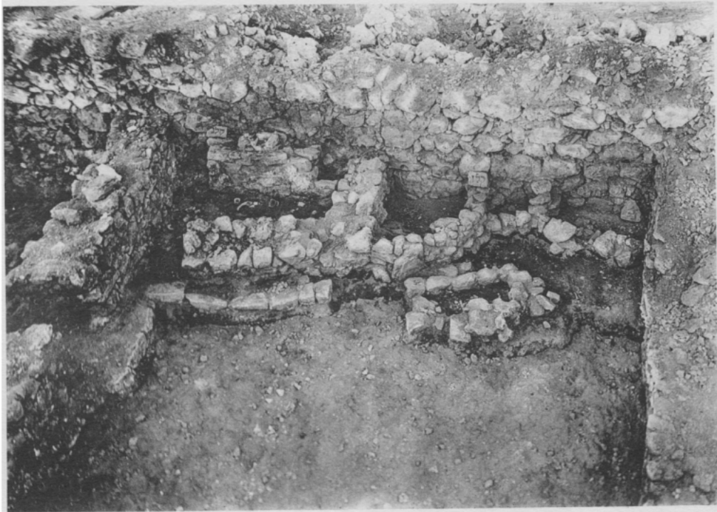
b. - Deuxième salle et saint des saints. Voir pl. LIII la vue d'ensemble du sanctuaire.
