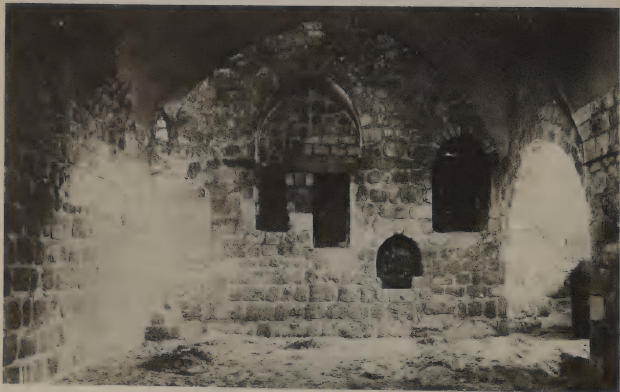
2 — Mur nord de la grande salle .
