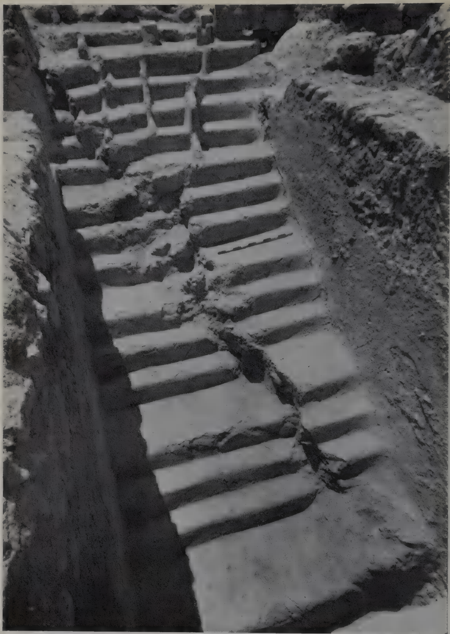
Citerne 48-49 fendue par le tremblement de terre; vers le sud-ouest.
