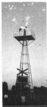
מיתקן כוח הרוח למילוי מצברים המספקים אור למחסומי הרכבת
